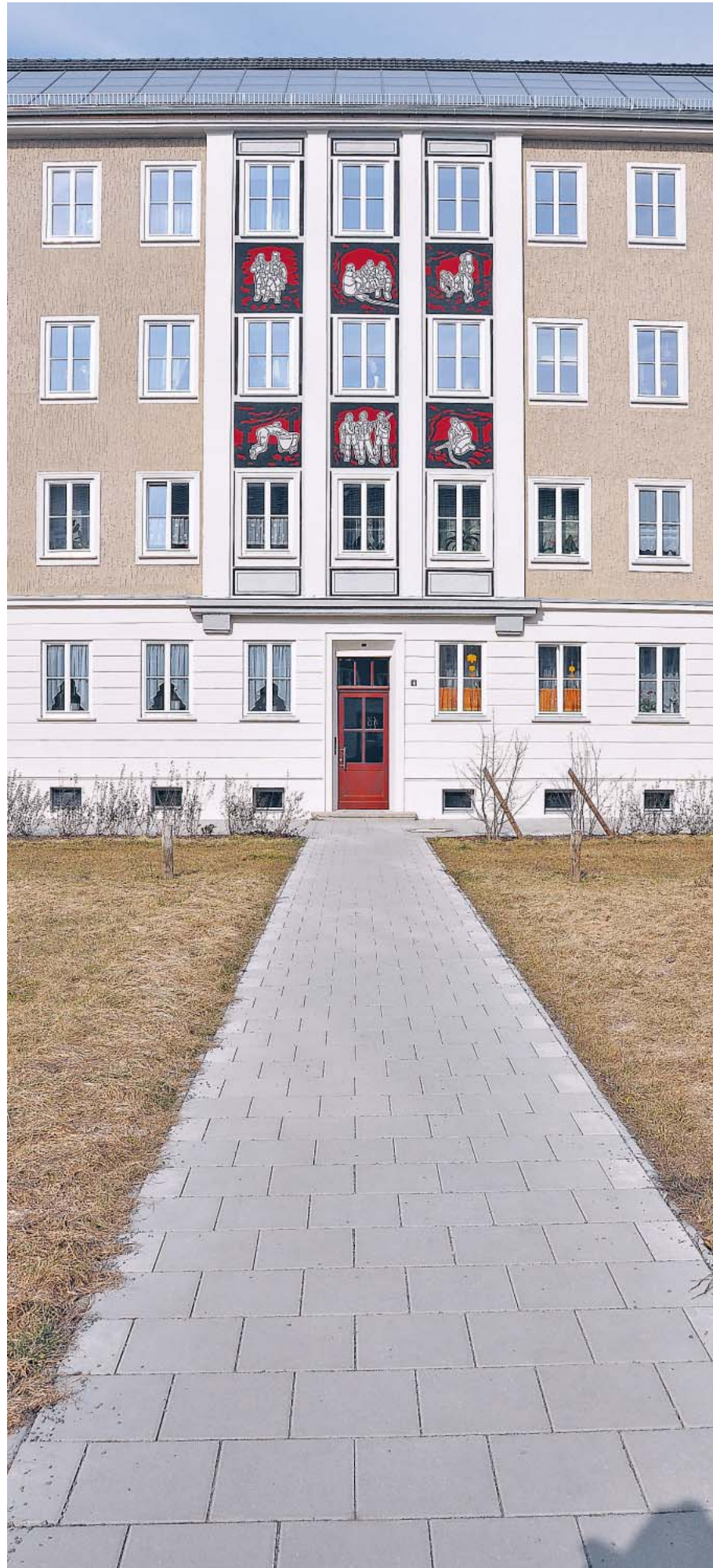
Sgraffito-Dekorationen auf Scheinkern im Stil des Sozialistischen Realismus feiern die Werktätigen in Stadt und Land in der Wohnsiedlung „Am Bergmann“. Foto Bartetzky
